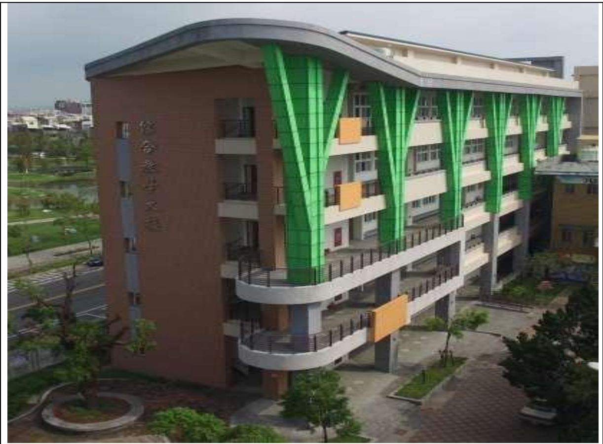
綜合教學大樓西北側
