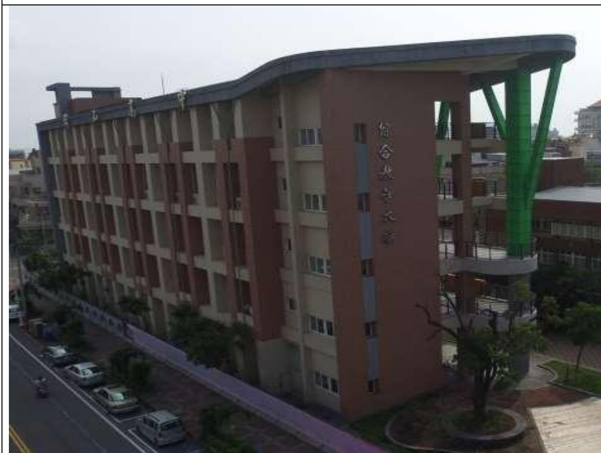
綜合教學大樓東北側
